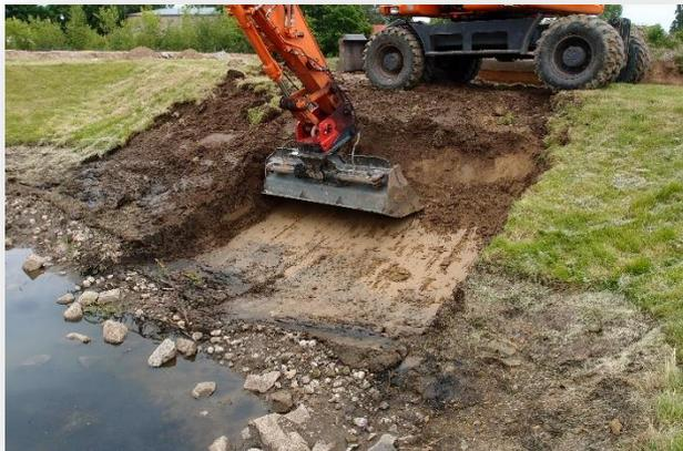
Aufgrabung und Kontrolle der Dichtung nach 2 Jahren
