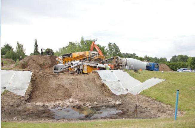
Herstellung einer Dichtung aus ZFSV
