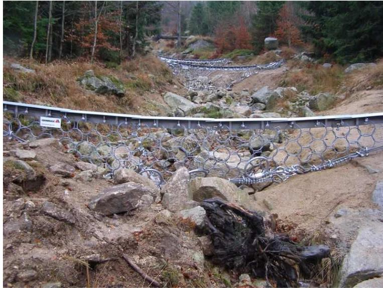
Abbildung 3: Dynamische Barrieren gegen Gesteinsschlammstrom.
